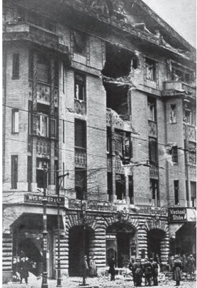
Das von Regierungstruppen zerstörte Vorwärtsgebäude
